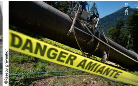
Ponçage d'une conduite forcée revêtue de peinture bitumineuse amiantée avec un robot équipé d'un dispositif d'aspiration des poussières à la source
