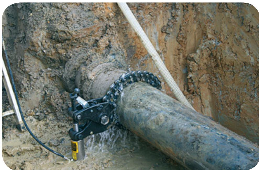
*Découpe de canalisation en amiante-ciment au coupe-tube.*
