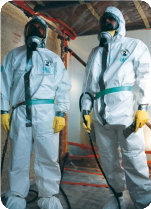
Masques complets à adduction d'air comprimé (avec filtres P3 en série).
