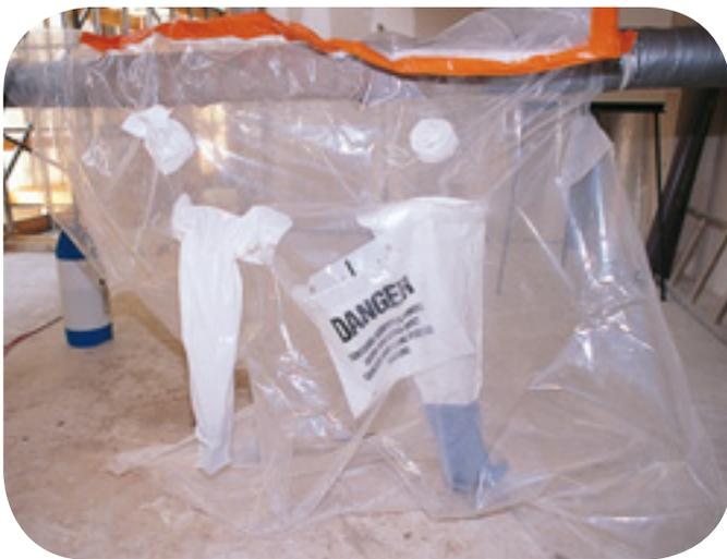
*Sac à gants pour le confinement d'une portion de canalisation horizontale.*
