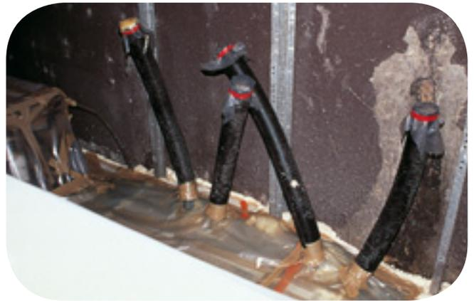
*Installation électrique mise hors-service et gaine de passage obstruée.*
