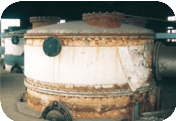
*Calorifugeage sur un réacteur chimique.*
