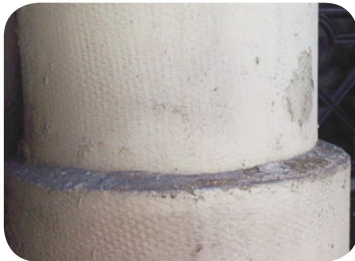
*Conduite en amiante-ciment à l'intérieur d'un local*
