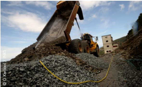
Le mouillage des sols doit être préalable à l'action de terrassement et continu lors de celle-ci, jusqu'au chargement.
