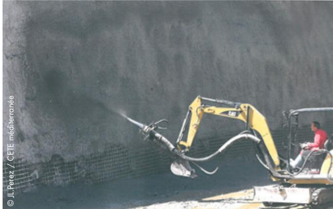
dans toutes les conditions de pente et est particulièrement adaptée pour les talus raides (pentes comprises entre 60 et 90°), jusqu'à la verticale, avec l'avantage de bien épouser la topographie. Projeté en voiles minces de quelques centimètres d'épaisseur, le béton agit comme une peau de confinement sur une paroi clouée, par exemple. Le béton se colore facilement permettant d'obtenir une meilleure intégration visuelle de la zone traitée dans le paysage environnant.
