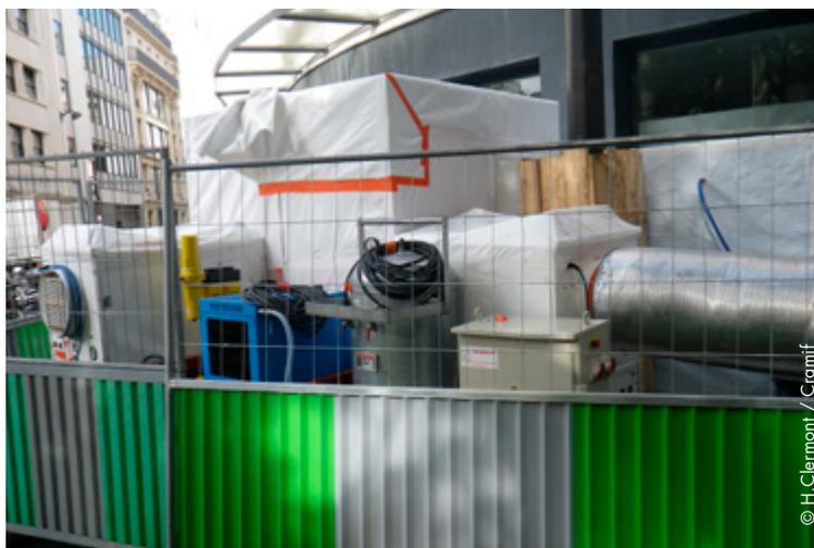
*Confinement localisé mis en dépression lors d'une intervention sur un réseau enterré dans un sol amiantifère en milieu urbain*
