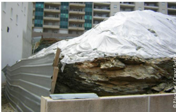
*Mise en place en cours d'un isolement de l'encrochement amianté en milieu urbain par bâchage*
